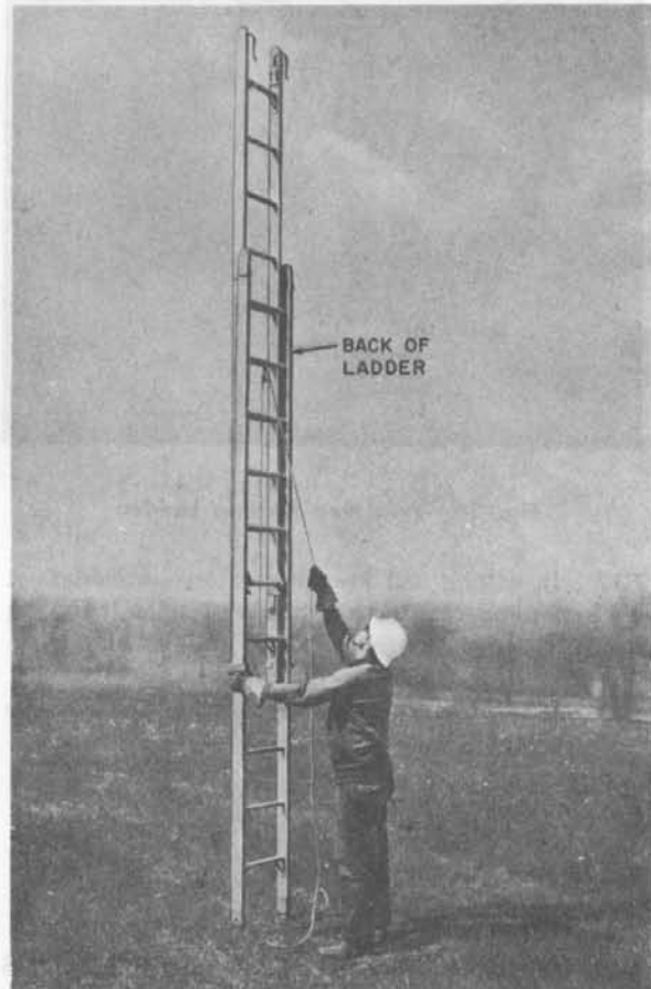
Fig. 29—Top Section Extended
