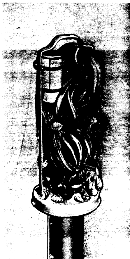
Fig. 12—B Cable Terminal
